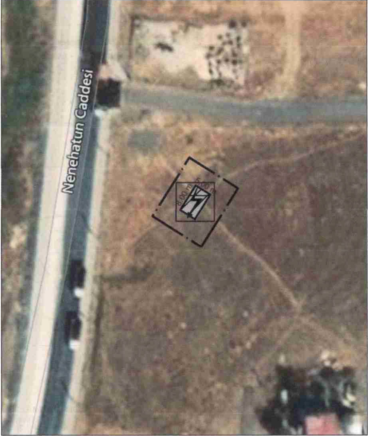
-Trafo Alanının Uydu Görüntüsündeki Konumu-
