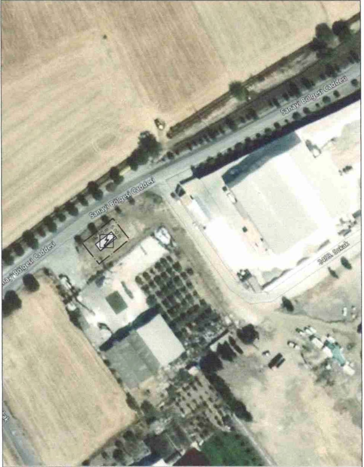
-Trafo Alanının Uydu Görüntüsündeki Konumu-
