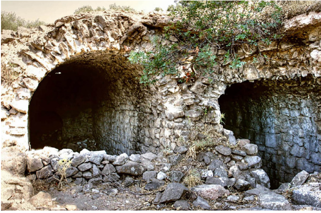
Fotoğraf 21 Gymnasion'un doğusunda yer alan hamamın tonozlu alt yapısı.
