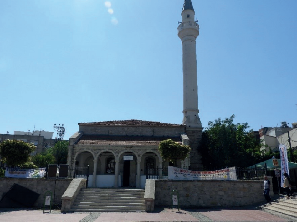
Fig. 16. Aliağa Çarşısı (Merkez) Camii. Kuzeyden görünüşü.
