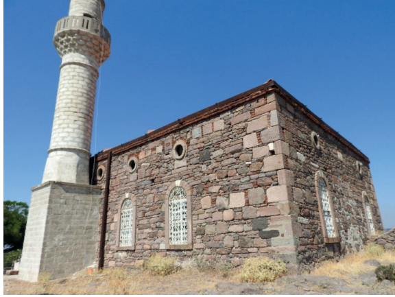
Fig. 39. Aliağa, Eski Hacıömerli Köyü Camii. Güneybatıdan görünüşü.
