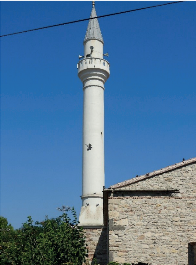
Fig. 18. Aliğa Çarşı (Merkez) Camii. Minare.
