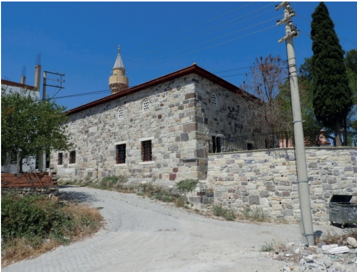
Fig. 3. Aliağa, Güzelhisar Köyü Balaban Paşa Camii. Güneydoğudan görünüşü.
