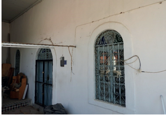
Fig. 43. Aliağa, Eski Hacıömerli Köyü Camii. Harim girişi.
