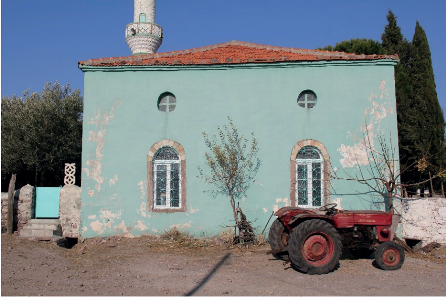
Fig. 28. Aliğa, Yukarışakran Köyü Camii. Güney cephesi.
