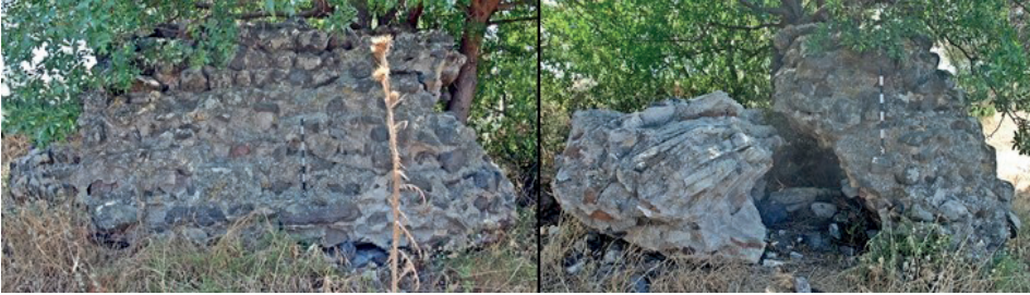
Fig. 17. Moloz taş ve harç kullanılarak yapılmış, duvar ve tonoz kalıntıları.
