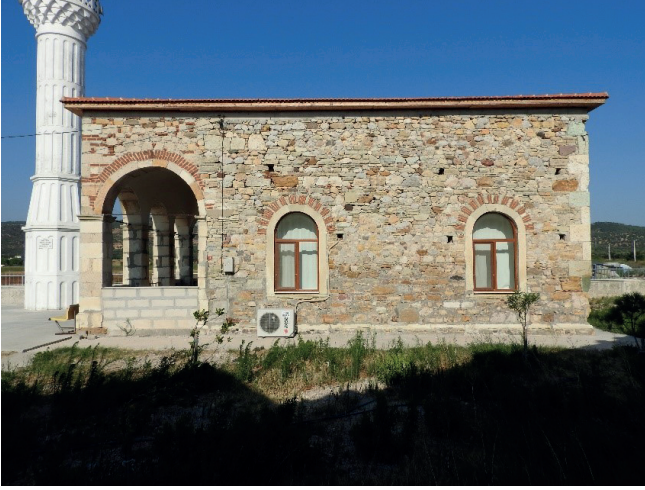
Fig. 34. Aliğa, Yenişakran Köyü Reşadiye Camii. Batı cephesi.
